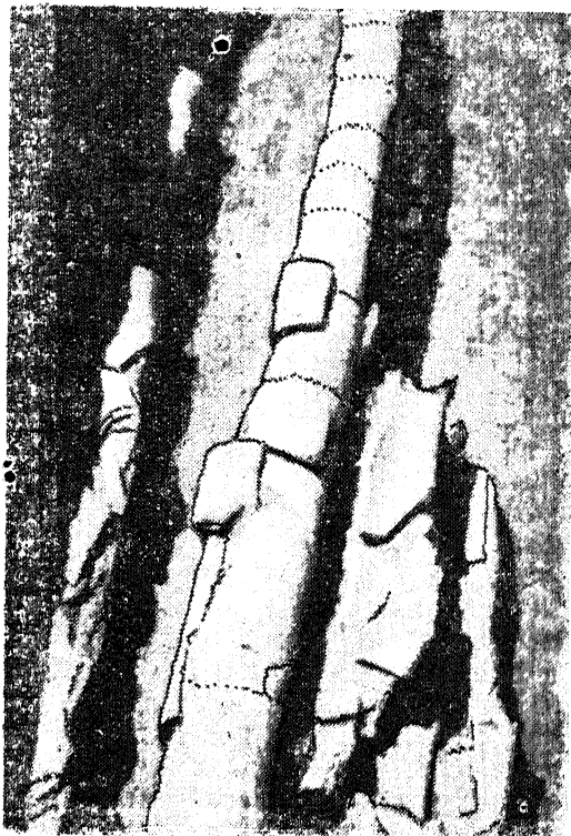
Шурф № 2. Четырехрядная линия водопроводной передачи.
